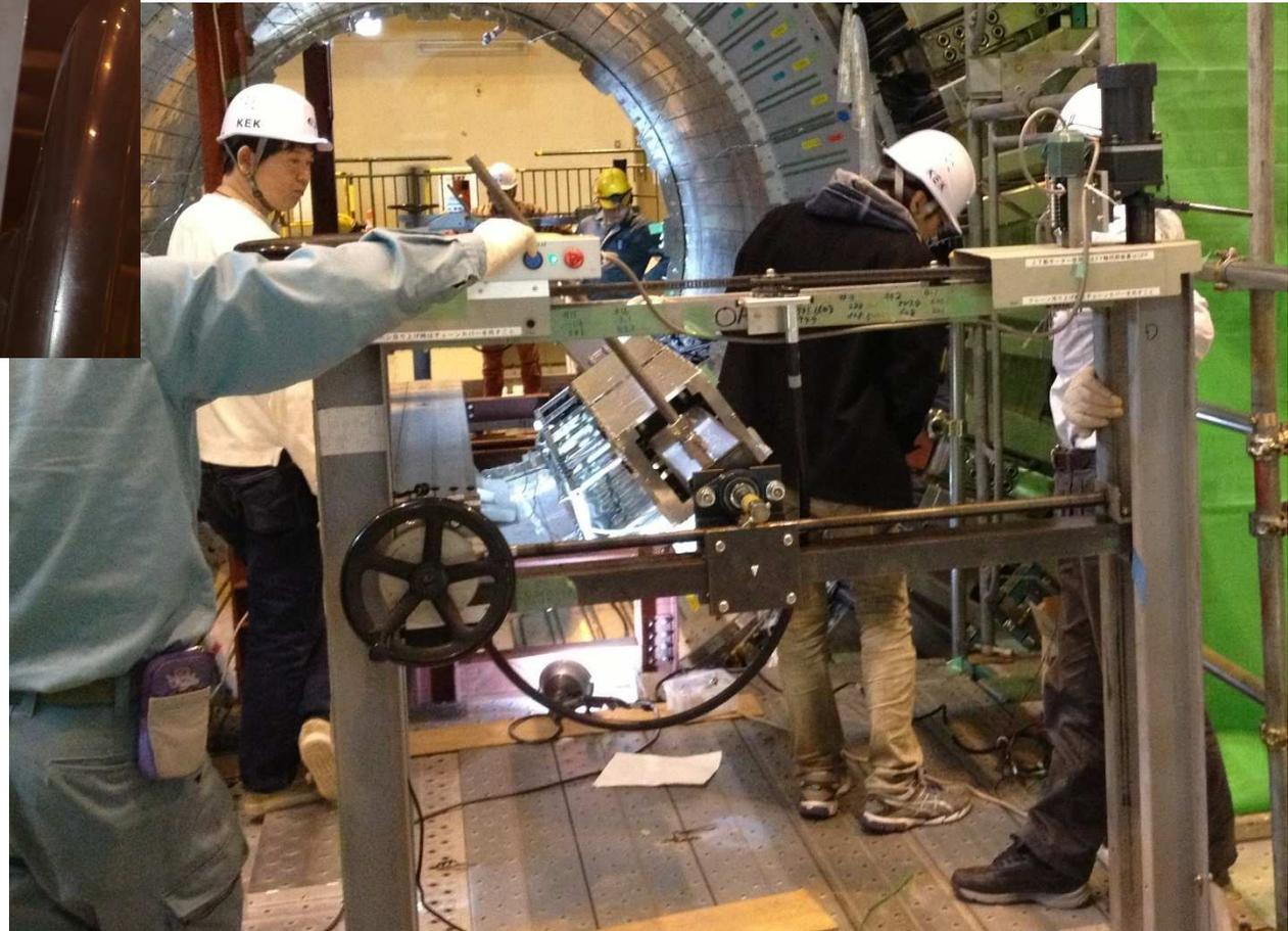
XY軸同期装置もテスト的に取付け
